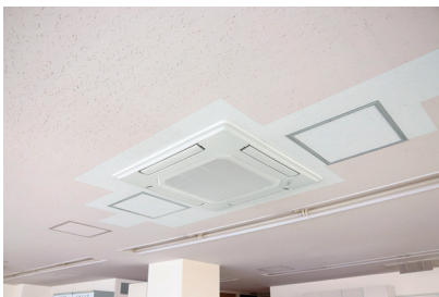
在来天井による設備更新例
